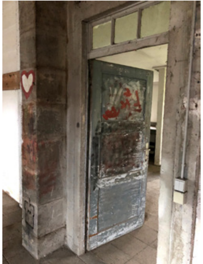
Ortsbegehung Arbeitsbaracke Breitenau, 29.11.2021 (Bild: Ann Katrin Düben)
