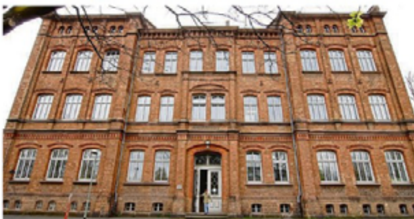
Am der Unterneustädter Schule unterrichtete Karl August Quer von 1922 an und praktizierte hier seine fortschrittlichen Ideen von Erziehung.
